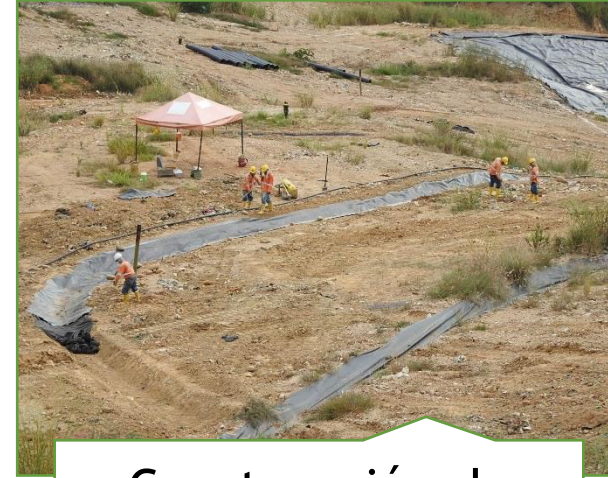
Construcción de canales de aguas lluvias en la celda 4.
